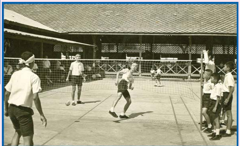
ภาพเรือนไม้ สนามตะกร้อ และทางซ้ายมือที่เป็นหลังคาลังกะสี ปัจจุบันคืออาคารไมเกล รัว
